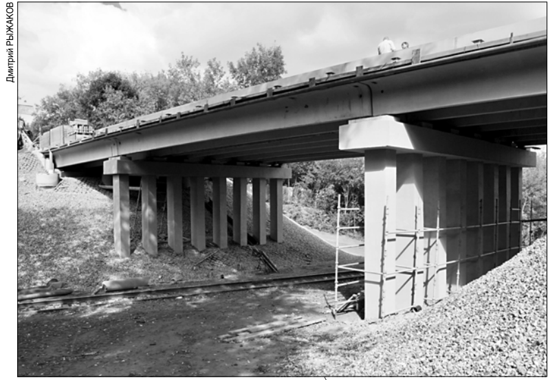
Мост на улице Зверева готов на 90%.
