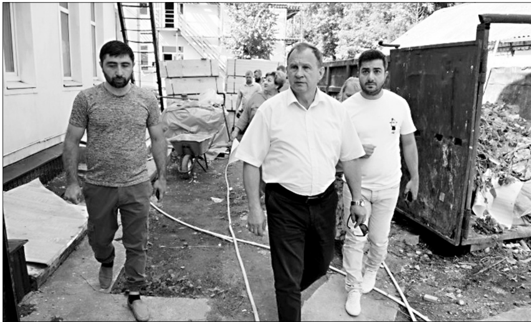
Александр Шаботинский проверил ход капитального ремонта в детсаду № 99.
